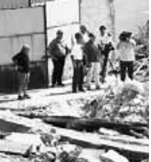
Dentro il cantiere. [P.P.]
