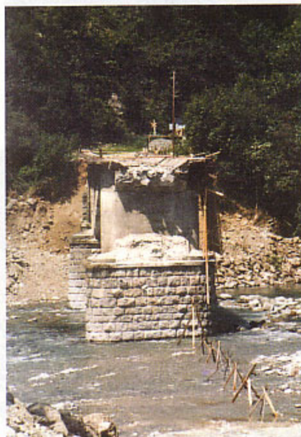
Foto 11 - Sbarramento parziale del torrente dopo la seconda volata (visto da sponda sinistra)
