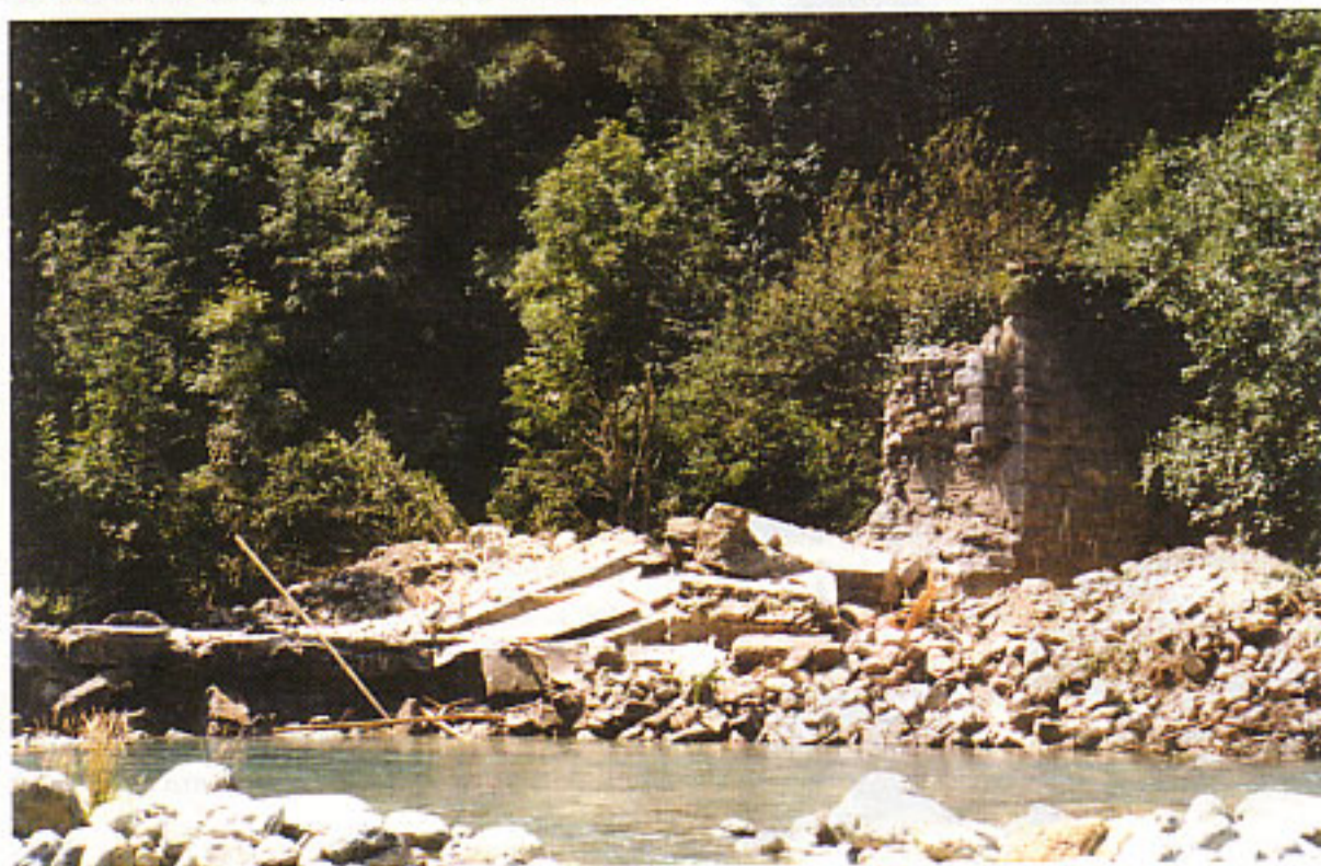
Foto 11 - Sbarramento parziale del torrente dopo la seconda volata (visto da sponda sinistra)
