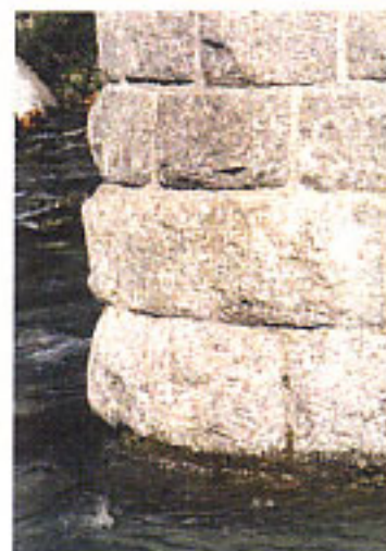
Foto 8 Particolare del rivestimento in pietra a vista di una pila
