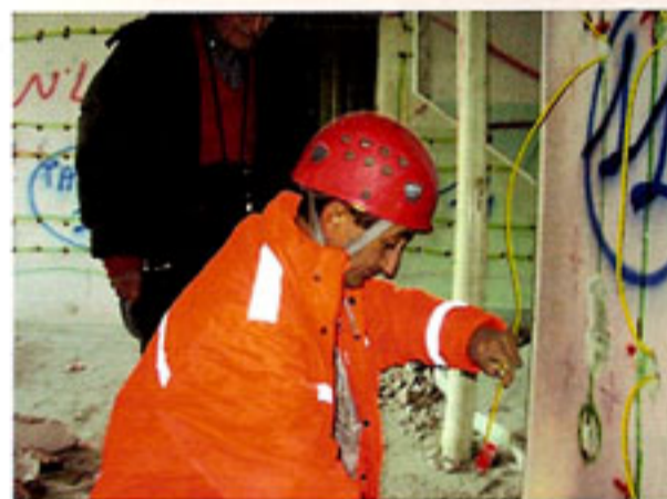
Figura 4 - Caricamento dell'esplosivo nei fori da mina
