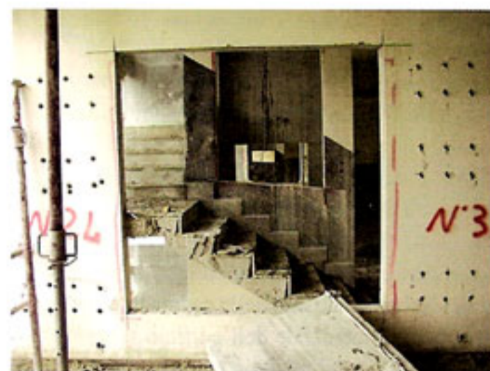
Figura 3 - Particolare degli indebolimenti strutturali realizzati con disco diamantato
